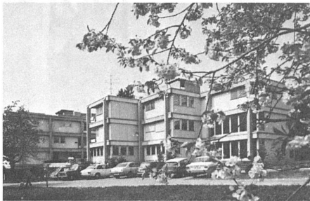
230 Mischnutzung: Wohnungen, Büros, zweigeschossiges Atelier (Rothausweg, Zug)
