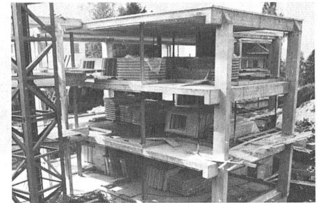
221 Vollerschlossene Nutzflächen, vorbereitet zur Montage der Einbaupakete
