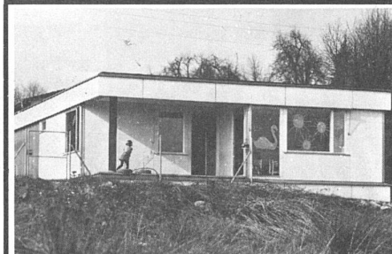
206 4D-Testgebäude Steinhausen, 3. Verwendungszustand (Kindergarten 1974)
