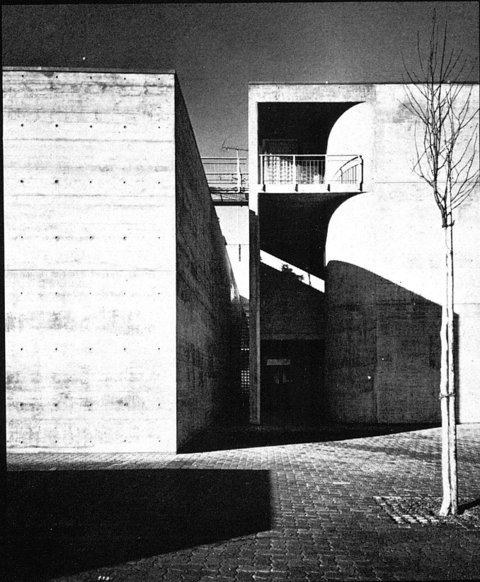
«Schlitz» im nördlichen Gebäudeteil des Schulhauses
