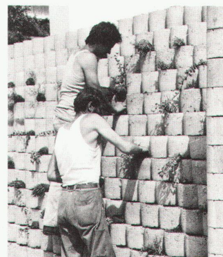
Die leicht begehbare Herbag-Böschungssteinmauer wird bepflanzt.
