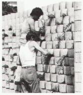
Die leicht begehbare Herbag-Böschungssteinmauer wird bepflanzt.
