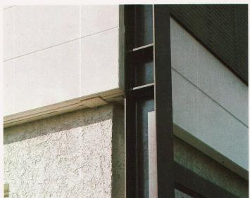
Nur Trockenbauweise gestattete eine Bauzeit von 3 Monaten. Deshalb für Fassaden, Boden und Dach Gasbeton-Elemente.
