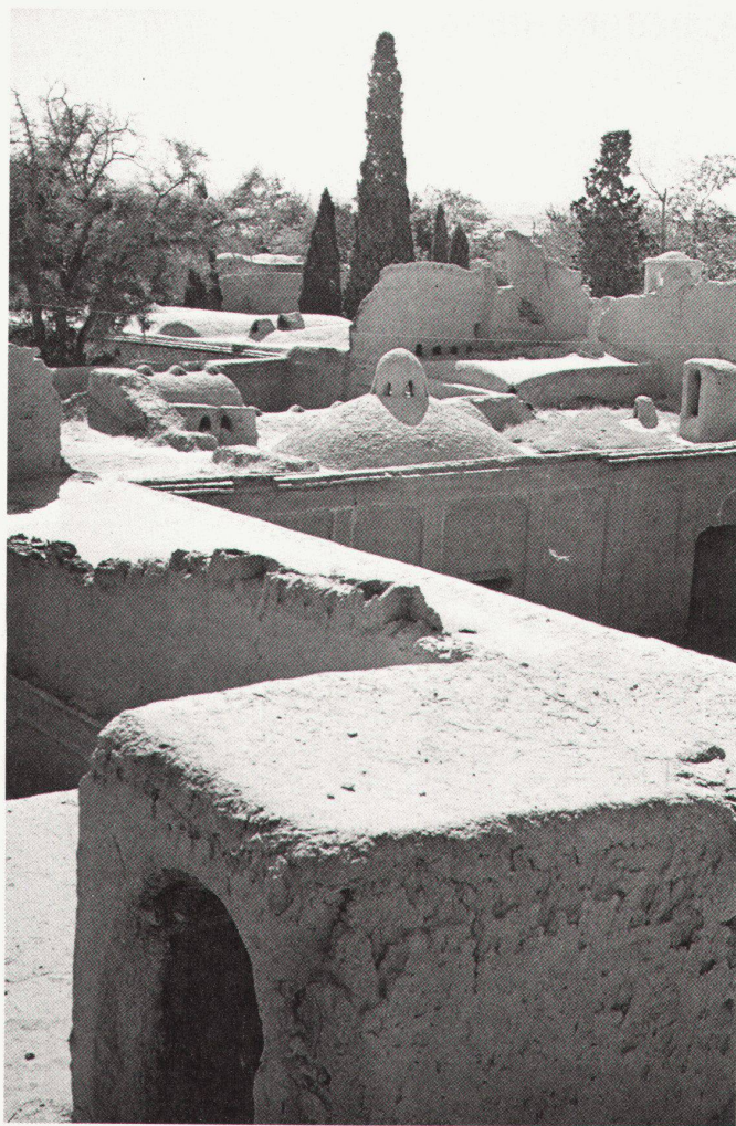
Begehbare Flachdächer und Lüftungstürme in Gonabad
