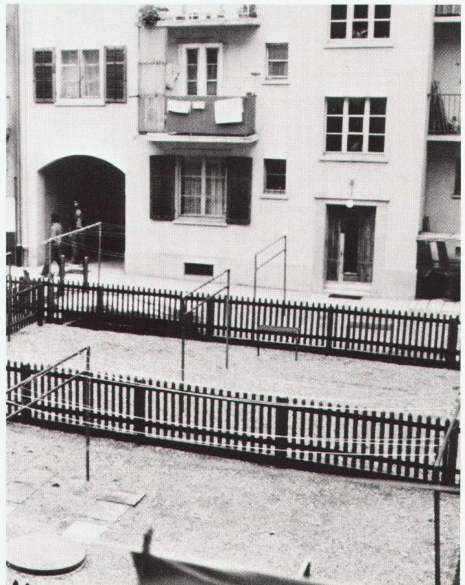
119 Zürich. Hofsanierung Rotachquartier. / Zurich. Aménagement d'une cour dans le Rotachquartier.
