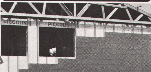
Hochwertiger Glasfaserbeton in der Fassadenausführung «standard» oder «nach Mass». Die hinterlüftete CEMFOR-Fassade setzt neue Massstäbe: Ausserordentlich widerstandsfähig gegen Beschädigung und alle Witterungseinflüsse • Formstabil • Nicht brennbar • Durchgefärbt oder versiegelte Acryldispersionbeschichtung • Wartungsfrei • Natürliche Alterung durch raffiniert geformte Oberfläche • Oberflächengestaltung nach Wunsch • Einfache Montage • Gute Bearbeitbarkeit • Preisgünstig.
