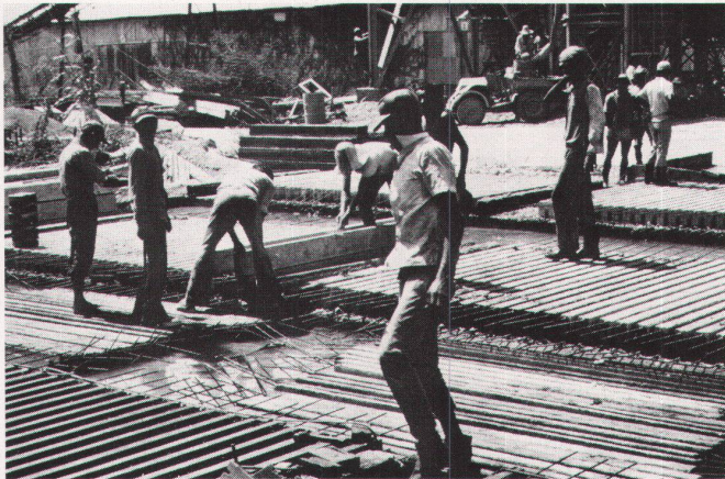
Beton-elemente werden vorfabriziert / Les éléments de béton sont préfabriqués
