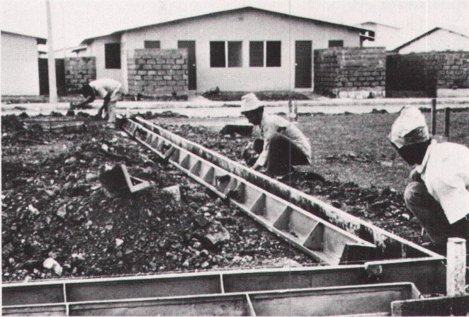
Vorbereiten der Streifenfundamente / Préparation des fondements
