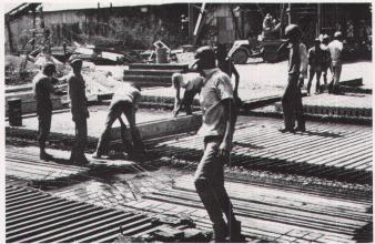
Betonelemente werden vorfabriziert / Les élémentés de béton sont préfa-
