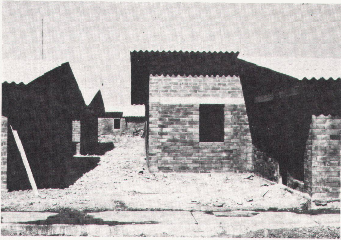
Rohbauten / Maisons brutes
