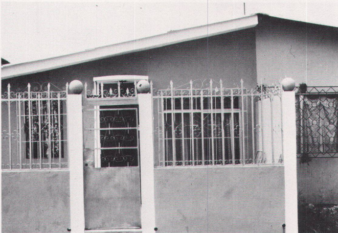
die Fenster vergittert... / grille les fenêtres...
