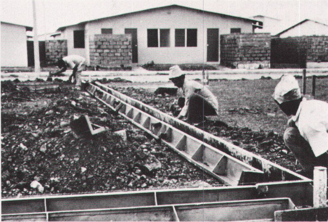
Vorbereiten der Streifenfundamente / Préparation des fondements
