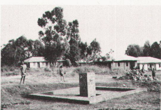
Helvetas: Brunnenanlage (Kamerun)
