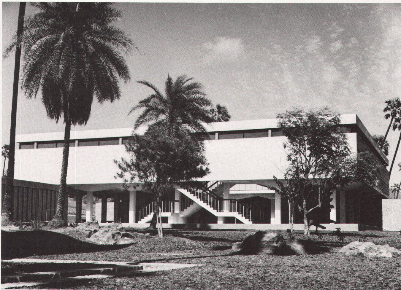
2 Suter & Suter, Architekten und Planer, Basel: Forschungszentrum Ciba of India, Bombay, Indien (1963) / Suter & Suter, architectes et planificateurs, Bâle: centre de recherches Ciba of India, Bombay, Inde (1963).
