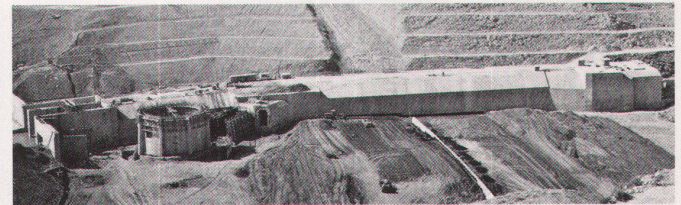
Elektrowatt: Staumauer (Marokko)
