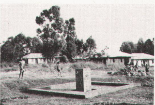
Helvetas: Brunnenanlage (Kamerun)
