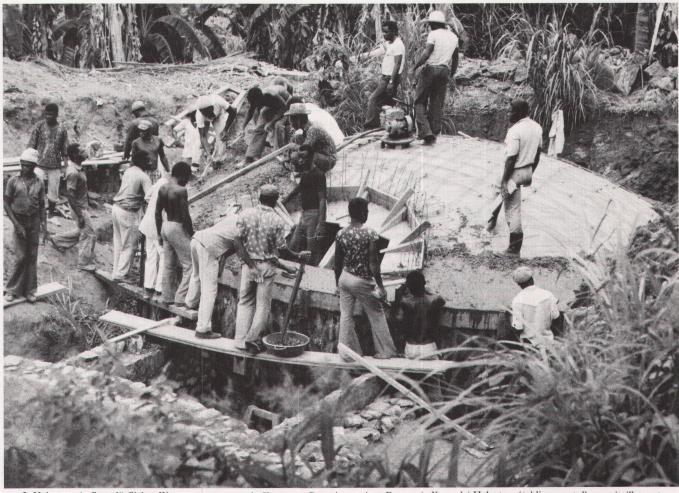
3 Helvetas: Aufbau dörflicher Wasserversorgungen in Kamerun. Betonieren einer Reservoir-Kuppel / Helvetas: établissement d'un ravitaillement en eau dans des villages au Cameroun. Voûte d'un réservoir en train d'être coulée.
