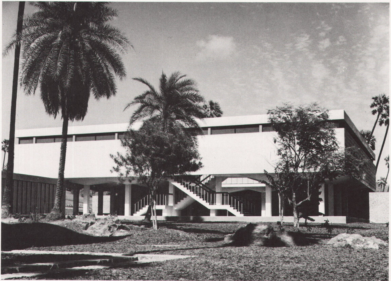
2 Suter & Suter, Architekten und Planer, Basel: Forschungszentrum Ciba of India, Bombay, Indien (1963) / Suter & Suter, architectes et planificateurs, Bâle: centre de recherches Ciba of India, Bombay, Inde (1963).
