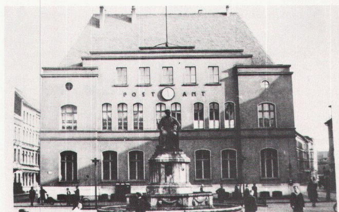
6 Umwandlung einer gotischen Posthausfassade in Köln-Kalk (1926–1927) / Transformation d'une façade d'un hôtel de poste originellement en style gothique à Cologne (1926–27).
