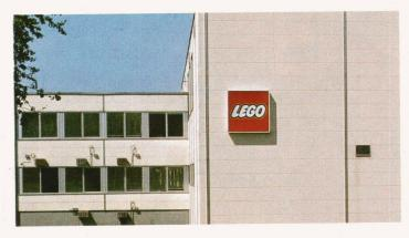
Das Montagebau-System mit Gasbeton-Elementen garantiert grösste Flexibilität auch bei späteren baulichen Vorhaben.
