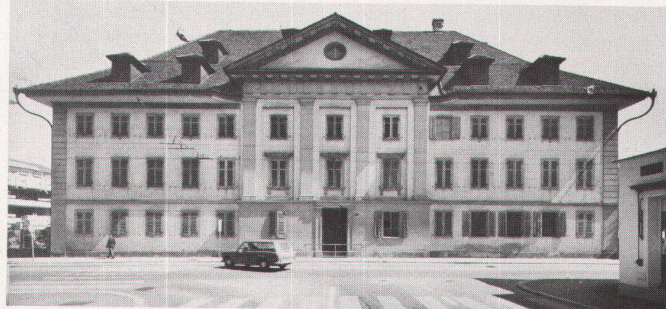
9 Luzern. Waisenhaus: vor der Rekonstruktion.
