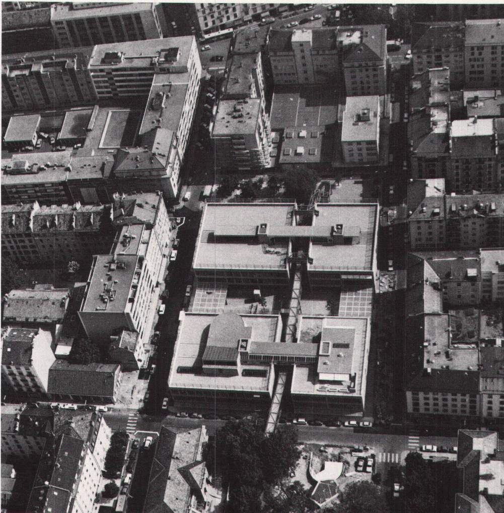
1 Situation im Quartier/situation dans le quartier (Foto: M. Oettli)
