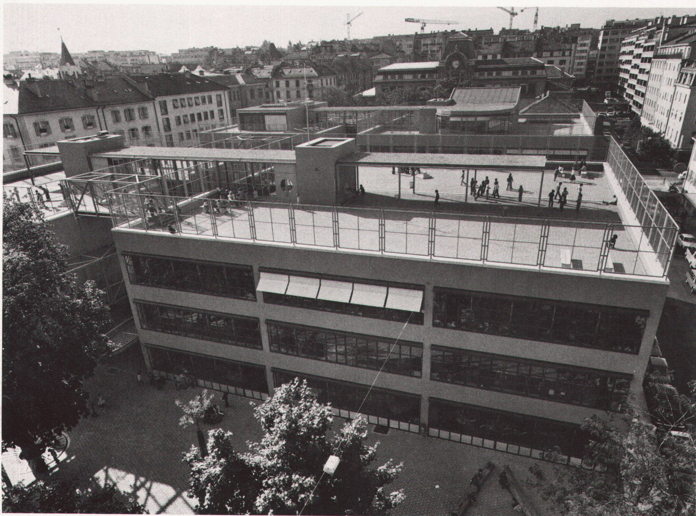
16 Ansicht von Südosten mit Dachterrasse/vue de sud-est avec les terrasses de toit
