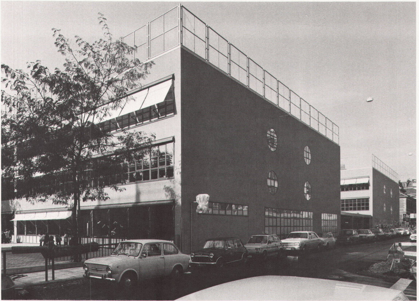
3 Fassade rue du Môle/façade rue du Môle
