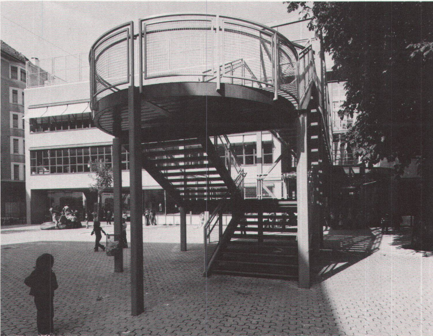
5 Ausgang zur Passerelle/montée à la passerelle
