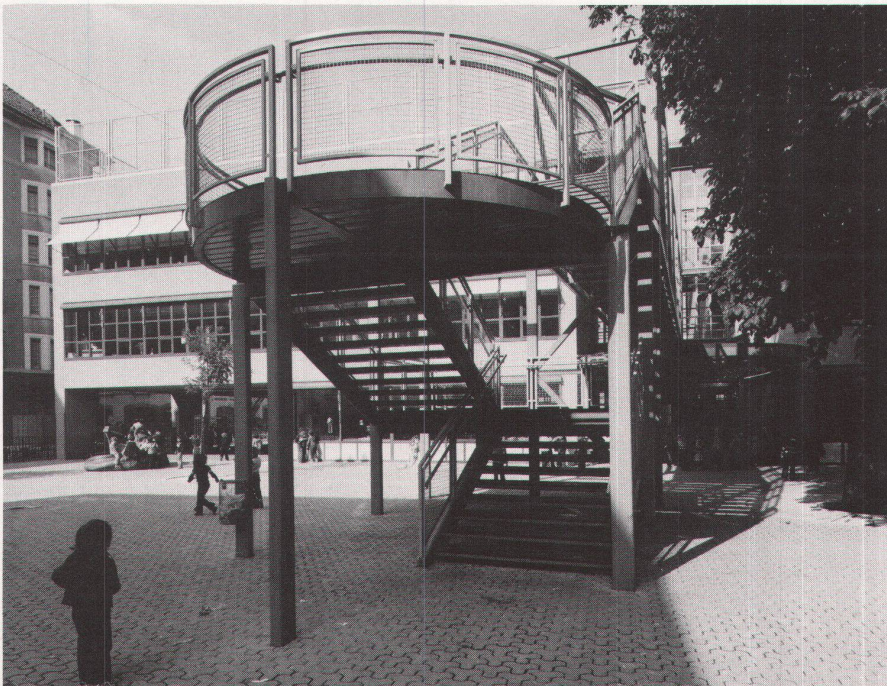
5 Ausgang zur Passerelle/montée à la passerelle
