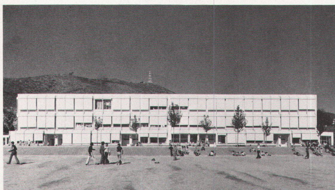
2 Escuela Thau; façade sud/Südfassade
