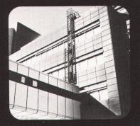
Die EDAK-Anlage ist energieunabhängig und wartungsfrei, sowie an Alt- und Neubauten montier- und einsetzbar.
