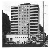
Wohnhochhaus in Luzern während der Sanierungsarbeiten. Die Metallunterkonstruktion «Aluhit-F» ist bereits angebracht, und mit der Montage der Platten wurde oben links begannen
