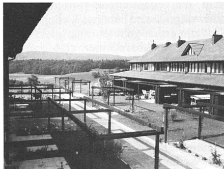
35 Überbauung / ensemble d'habitation Haberacher bei / près de Baden AG (Metron Architekten).
