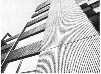
DURISOL-Fassadenelemente sind dreischichtig. Ein hochisolierender Kern wird beidseitig von einer Feinbetonschicht umschlossen. Durch ein besonderes Härtungsverfahren erhält die Aussenschicht ihre Wetterbeständigkeit und die helle Tönung. Sie wird weder gestrichen noch sonstwie behandelt, kann aber auch in Rippenbeton-, Wasch- Feuchtigkeitshaushalt.
