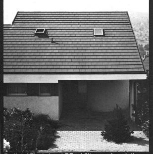
Redland Flachziegel RF erhält man eine glatte, ruhige, die Horizontale leicht betonende Dachfläche. Die Deckbreite des Normalziegels ist 30 cm, die Lattenweite ist variabel bis max. 34 cm. Dies ermöglicht ein Umdecken ohne neue Lattung. Ein reichhaltiges Zubehör ergänzt das Braas-Redland-Betonziegelprogramm.
