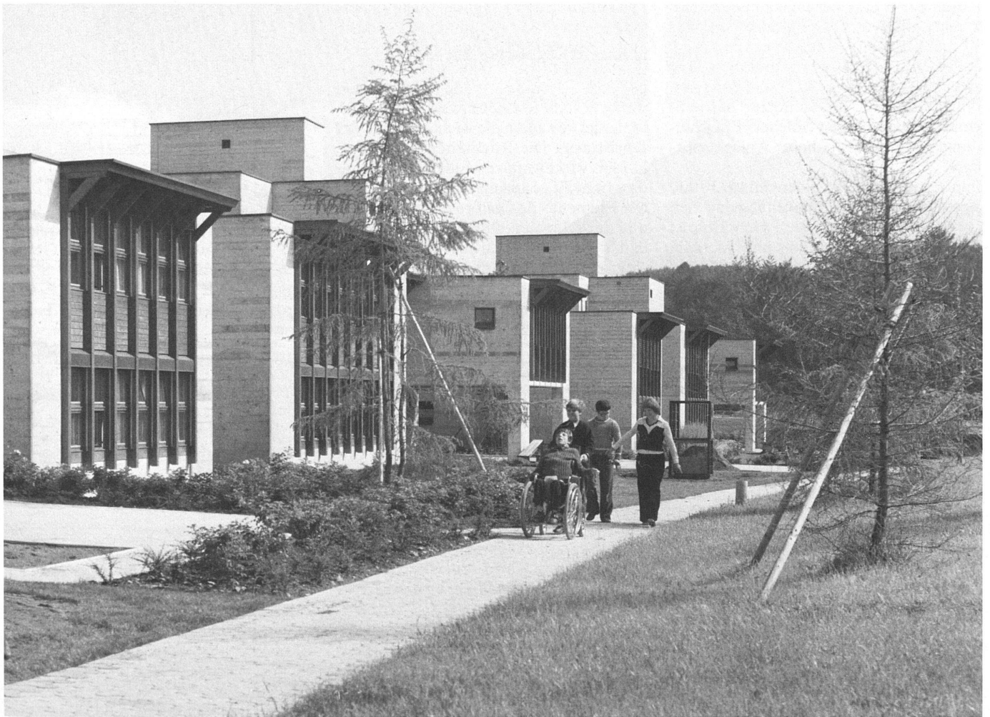
1 Wohnhäuser von Südwesten / maisons d'habitation
