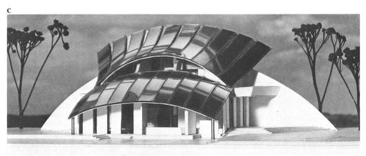
18 Bähr und Gansfort, Architekten/architectes: Wohnhaus mit kurvenförmigen und horizontalen Kollektoren verschiedener Ausrichtung (Modellaufnahme)/maison munie de collecteurs horizontaux et disposés en courbe (maquette).
