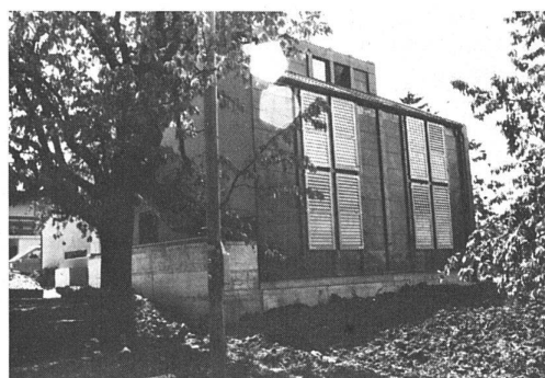
4-7 Haus in/maison à Dornach, SO. Technische und natürliche Sonnenheizung: Haus mit Wintergarten und Dachkollektoren/chauffage technique et naturel: maison avec jardin d'hiver et collecteurs solaires arrangés sur le toit.
