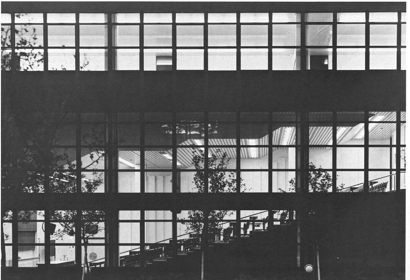
11 Hörsaal Baustoffkunde von aussen
