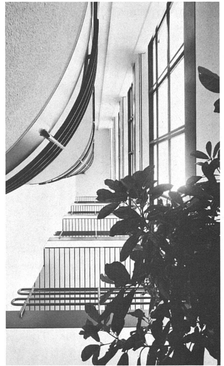
18 Treppenaufgang in einem Schultrakt
