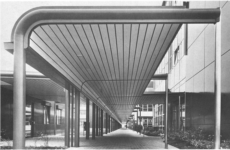
5 Verbindungsweg, links Abwartwohnungen, rechts Schultrakte
