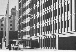
Les éléments peuvent être posés derrière, entre ou devant la construction porteuse. Dans les deux premiers cas la construction porteuse reste visible (fig. 44), dans le troisième cas elle peut être cachée (fig. 45).
