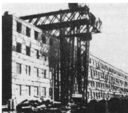
4 Wohnhäuser in Grossblockbauweise/immeubles d'habitation préfabriqués. Experimentalbau in Leningrad/réalisation expérimentale à Leningrad, 1932. (Nach/d'après Hans Schmidt, Aufsätze zur Architektur).
