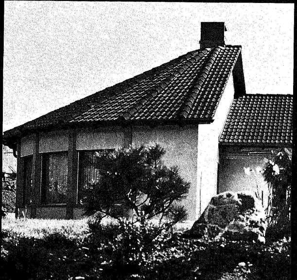
Der Braas-Redland Pfannenziegel wird mit glatter oder besandeter Oberfläche hergestellt. Der besandete Ziegel eignet sich besonders für Höhenlagen über 800 m, da er wirksam das Abgleiten von Schnee verhindert.
