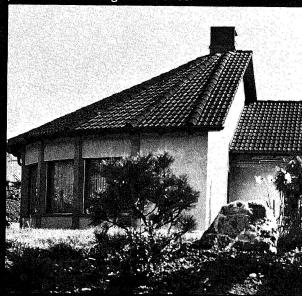
Der Braas-Redland Pfannenziegel wird mit glatter oder besandeter Oberfläche hergestellt. Der besandete Ziegel eignet sich besonders für Höhenlagen über 800 m, da er wirksam das Abgleiten von Schnee verhindert.
