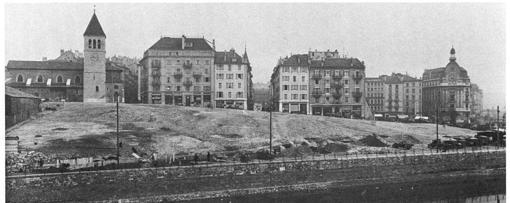
62 ... und/et nach den Abbrucharbeiten / après les démolitions 1932.
