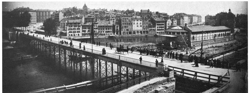
61 Quartier de Seujet vor den Abbrucharbeiten, 1890 ...
