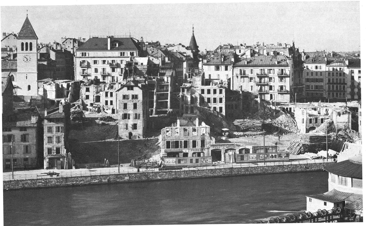
63 Quartier du Seujet, während der Abbrucharbeiten / pendant les démolitions, 1930.
