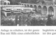
Rasters entworfen worden. Dadurch wurde es möglich, die oberen Geschosse in Vorfabrikation zu erstellen. (...) Fenster- und Fassadenelemente sind ebenfalls vorfabriziert. (...) Herr Lipski begleitete als neutraler Farbberater den ganzen Bau.»
