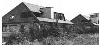
Der Architekt, zugleich einer der beiden Bauherren, benützte nun das Flachdach als Geschossdecke und baute darüber einen Dachstuhl. Eine zeitgemäss Dachkonstruktion mit braunen Dachziegeln «Eternit» und gu-
