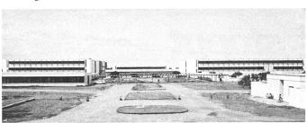
wurde ein Duripanel-Elementbausystem gewählt, das sich für die eingeschossigen Bauten und in Kombination mit der tragenden Stahlkonstruktion auch für die zwei- bis vierstöckigen Gebäude eignete. Die Stahlskelette bestehen aus einfachen Rahmenkonstruktionen, deren Stützen und Verbindungsmittel aus der Schweiz, die restlichen Teile aus Tunesien geliefert wurden. Die
