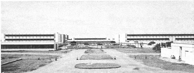
wurde ein Duripanel-Elementbausystem gewählt, das sich für die eingeschossigen Bauten und in Kombination mit der tragenden Stahlkonstruktion auch für die zwei- bis vierstöckigen Gebäude eignete. Die Stahlskelette bestehen aus einfachen Rahmenkonstruktionen, deren Stützen und Verbindungsmitte aus der Schweiz, die restlichen Teile aus Tunesien geliefert wurden. Die
