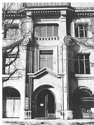
Détail de la façade est (photo Yves Blanc).
