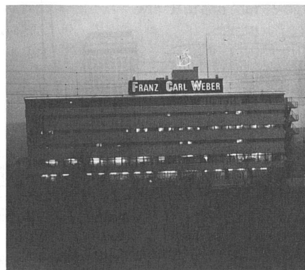
3 Franz Carl Weber, Lagerhaus/Entrepôt Franz Carl Weber, Zürich-Schlieren.
