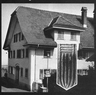
Der «Biber alt» ist ein rustikaler Tondachziegel, der in allen Teilen der Spitzenqualität moderner Ziegel entspricht, aber in Form und Farbe dem früheren Handziegel gleicht. So hat er beispielsweise eine «handgestrichene» Oberfläche und erhält vor dem Brennen seine unregelmässige Farbe. Dieser Ziegel eignet sich speziell für die stilgerechte Restauration erhaltenswerter Gebäude.
