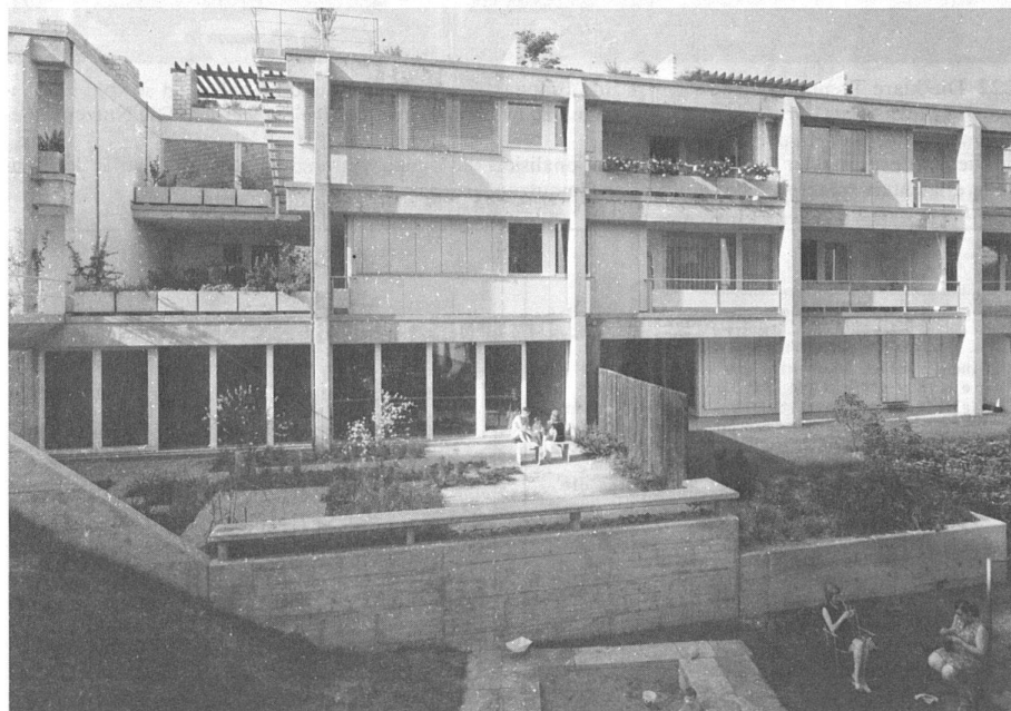
233 Unabhängige Tragstruktur und freier Fassadenverlauf. Vielfältiges Erscheinungsbild mit nur 6 verschiedenen Fassadenelement-Typen serieller Herstellung (Rothausweg, Zug)
