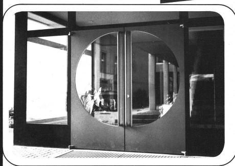
Eingangspartie in Leichtmetall-Konstruktion
