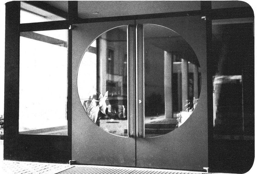
Eingangspartie in Leichtmetall-Konstruktion
