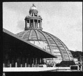
8) Die Wiederherstellung der ursprünglichen ETH-Kuppel, de-ren authentische Struktur zur Verbesserung der Isolierung freigelegt werden musste, bot die Möglichkeit, unter einer gleich strukturierten Glashaut zwischen den kräftigen Betonrippen Sonnenkollektoren unsichtbar zu montieren und den Beweis anzutreten, dass sich die ETH auch mit bescheidenen, dezentralisierten
