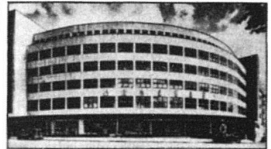
Suvahaus, Bern. Gesamtansicht.
