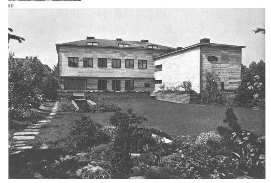
den, da durch das Wegfallen der Klappläden der Abstand der Fenster frei wählbar wird. Dach extrem flach geneigt und zurückgesetzt.
