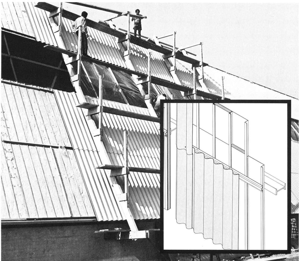
Nämlich die Wetterhaut, die Hinterlüftung, die Wärmedämmung und die Innenwandverkleidung.
