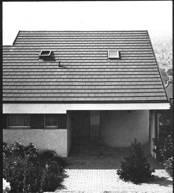
Redland Flachziegel RF erhält man eine glatte, ruhige, die Horizontale leicht betonende Dachfläche. Die Deckbreite des Normalziegels ist 30 cm, die Lattenweite ist variabel bis max. 34 cm. Dies ermöglicht ein Umdecken ohne neue Lattung. Ein reichhaltiges Zubehör ergänzt das Braas-Redland-Betonziegelprogramm.
