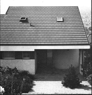
Redland Flachziegel RF erhält man eine glatte, ruhige, die Horizontale leicht betonende Dachfläche. Die Deckbreite des Normalziegels ist 30 cm, die Lattenweite ist variabel bis max. 34 cm. Dies ermöglicht ein Umdecken ohne neue Lattung. Ein reichhaltiges Zubehör ergänzt das Braas-Redland-Betonziegelprogramm.
