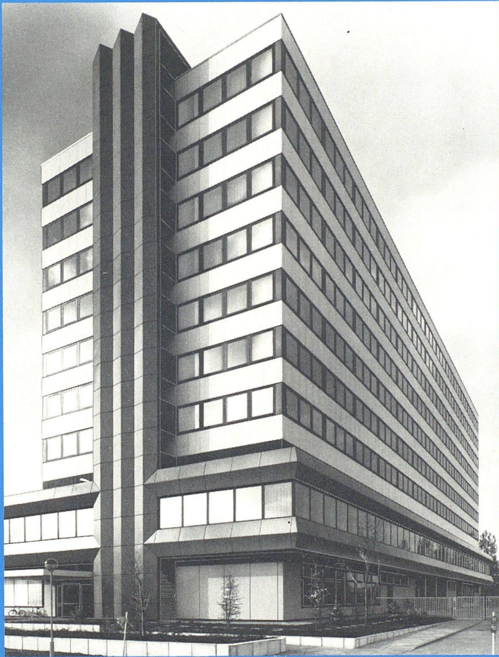
OPD Datenzentrum, Hannover: Ein Beispiel für eine Fassadengestaltung mit der wärmedämmten Aluminium- Konstruktion Allzweck 54 w und Aluminium-Platten, farbbeschichtet.
