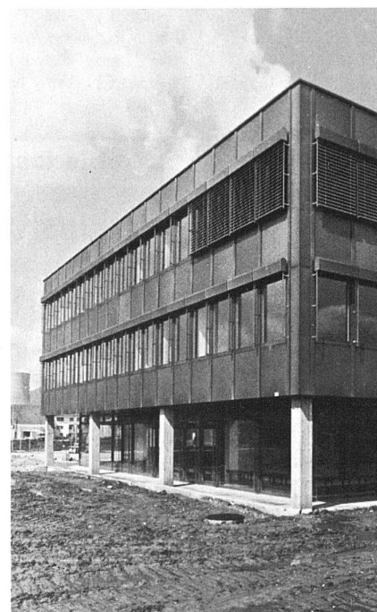
Gemeindeforum 4658 Däniken 168 Verbund-Raffstoren VR90 mit Motorantrieb Architekt: Hans Zaugg, Architekt SIA/BSA, Olten
