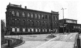
Die Rote Fabrik von der Seestrasse aus gesehen
