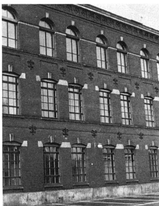
Ausschnitt aus der Fassade des Hauptgebäudes
