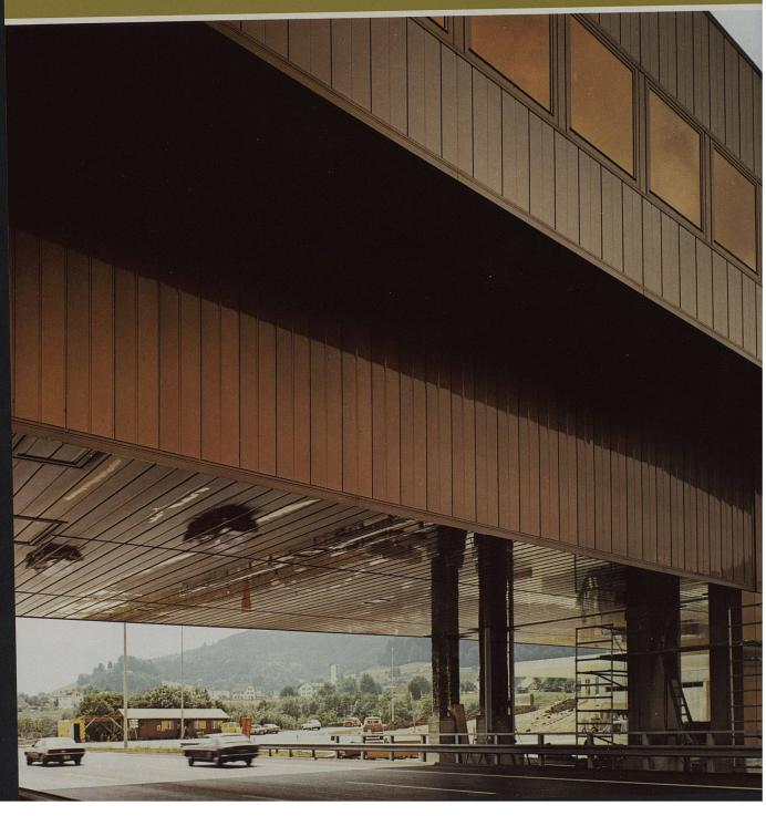
Grosse, fensterlose Fassadenflächen in einer Grosse, fensterlose Fassadenflächen in einer Grossenspruchsvoll geplanten Neubauzone. Gelöst mit der LUXALON® Aluminium-Fassade Typ 150 F. Das ausgefeilte System von Tragerippe und Paneel entspricht den bauphysikalischen Forderungen. Das ist /oraussetzung. Der gestalterischen Freiheit sind durch die breite Farbskala kaum Grenzen gesetzt.
