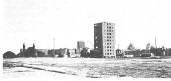
eines Vibrationstests, um seine Erdbebenfestigkeit zu prüfen / Le dernier bâtiment debout, objet d'expériences de vibrations pour mesurer sa résistance aux tremblements de terre; 18 septembre 1976 (Foto C.A. Cramer).
