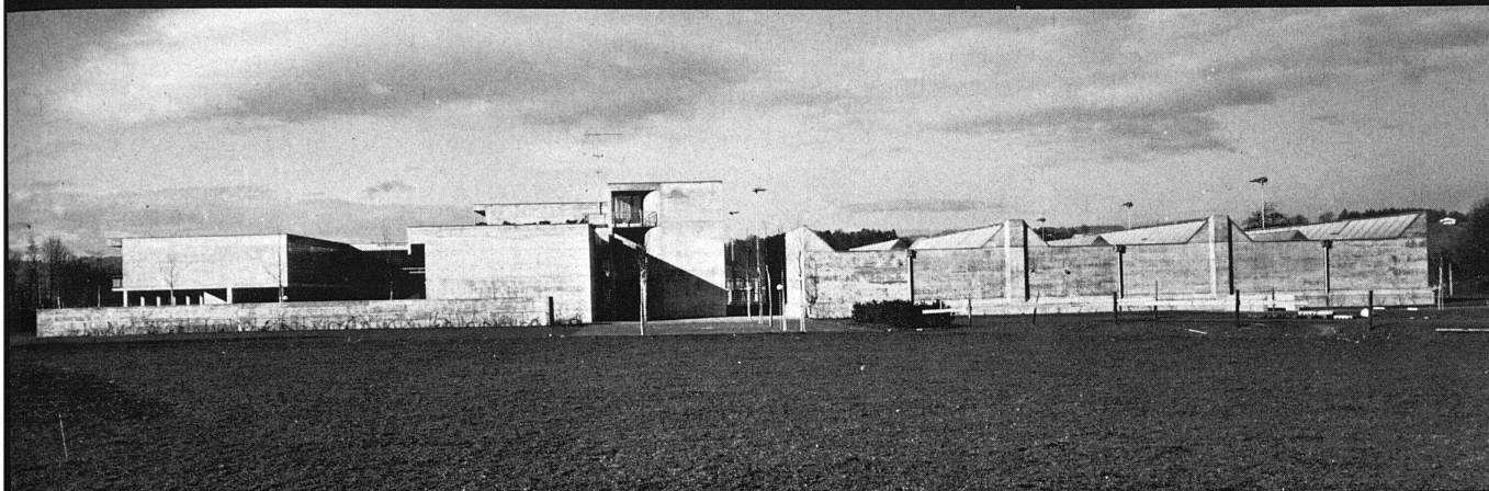
Gesamtansicht von Osten
