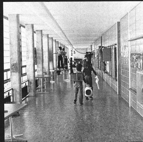
Korridor vor den Klassenzimmern
