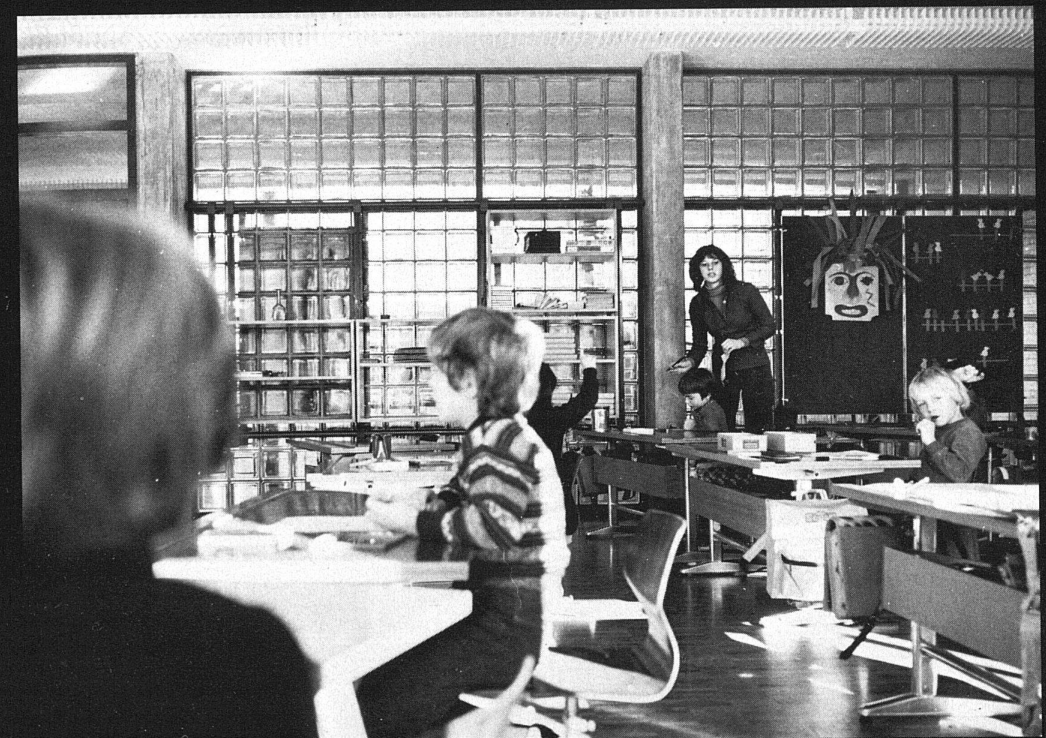
Trennwand zwischen Klassenzimmer und Korridor
