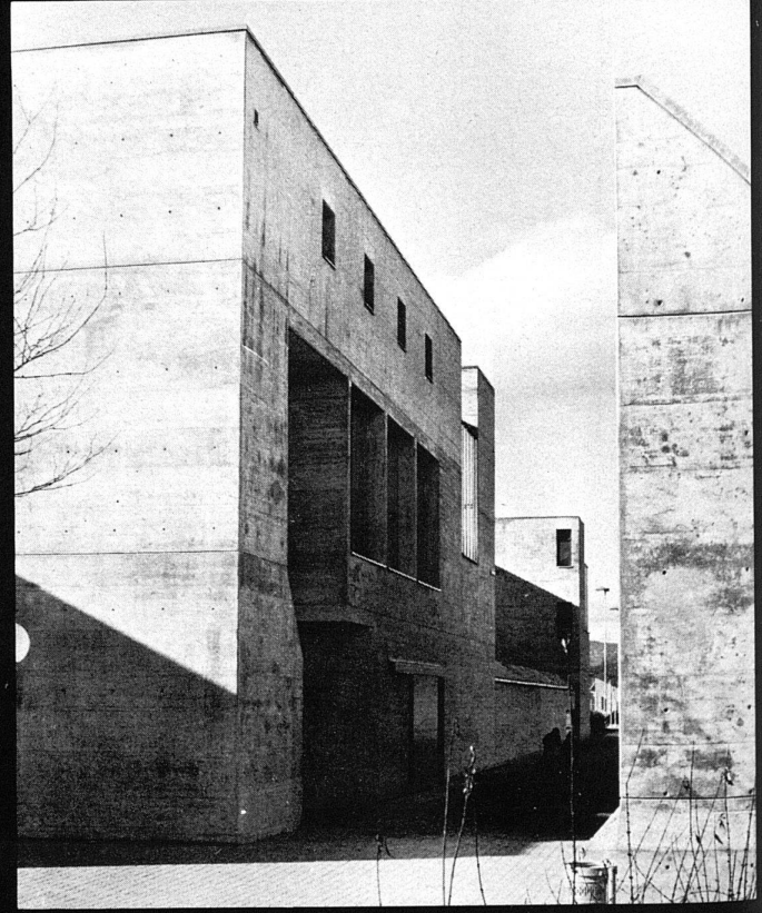
Detailansicht der Nordfassade des Schulhauses
