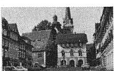
G 1. ZENTRUM DES FLECKENS Aufnahmekategorie A: Ursprüngliche Substanz von Bauten und Freiräumen mit ausgeprägten epochenspezifischen oder regionaltypischen Merkmalen als Ganzheit vorhanden
