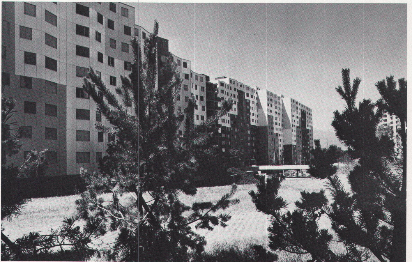
Hof nach Nordwesten, im Hintergrund Fussgängerbrücke
