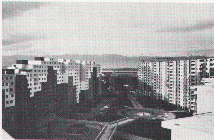
Der braune Hof von Südwesten
