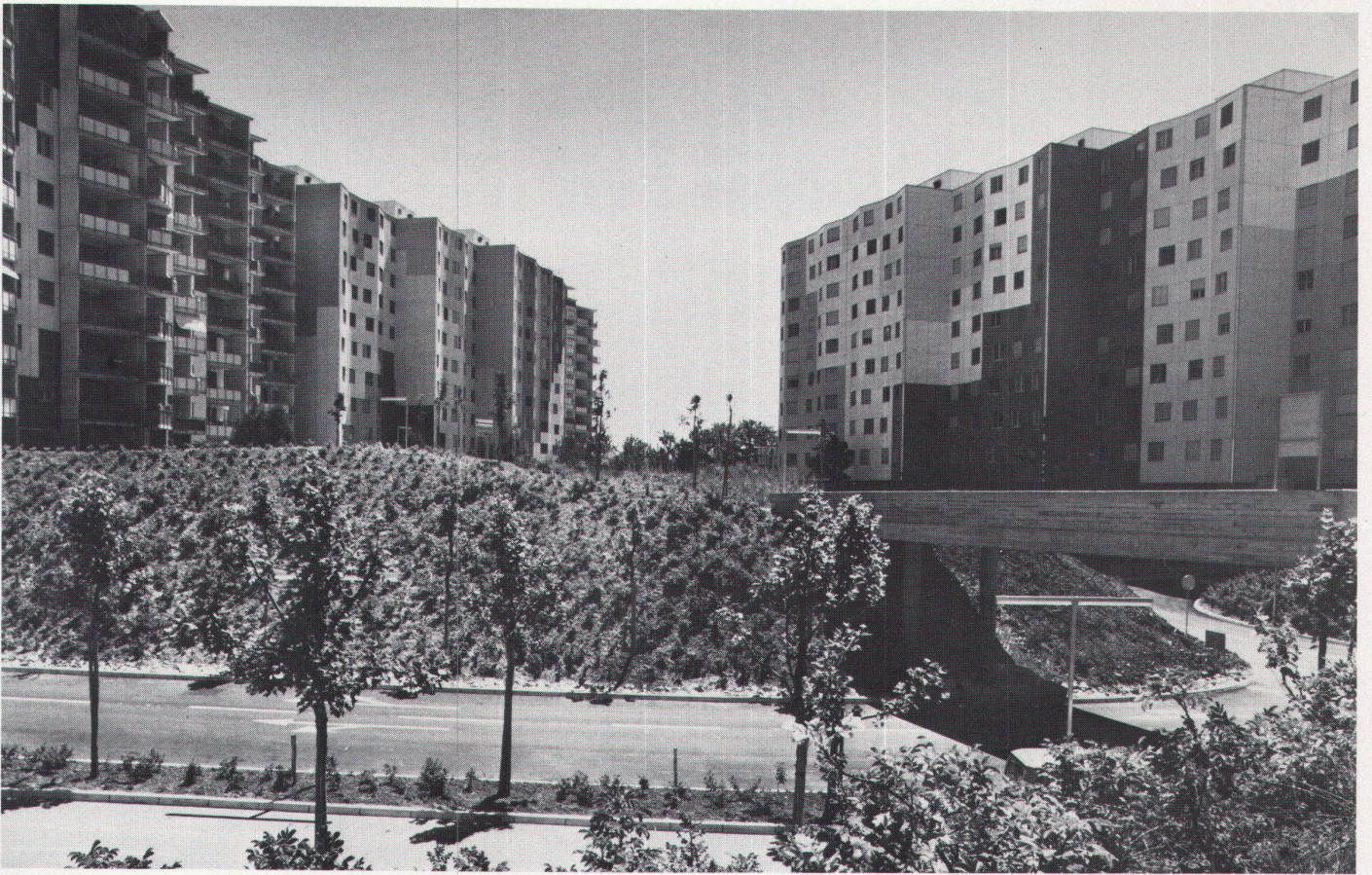
Hof von Nordwesten mit Haupteinfahrt und Fussgängerbrücke
