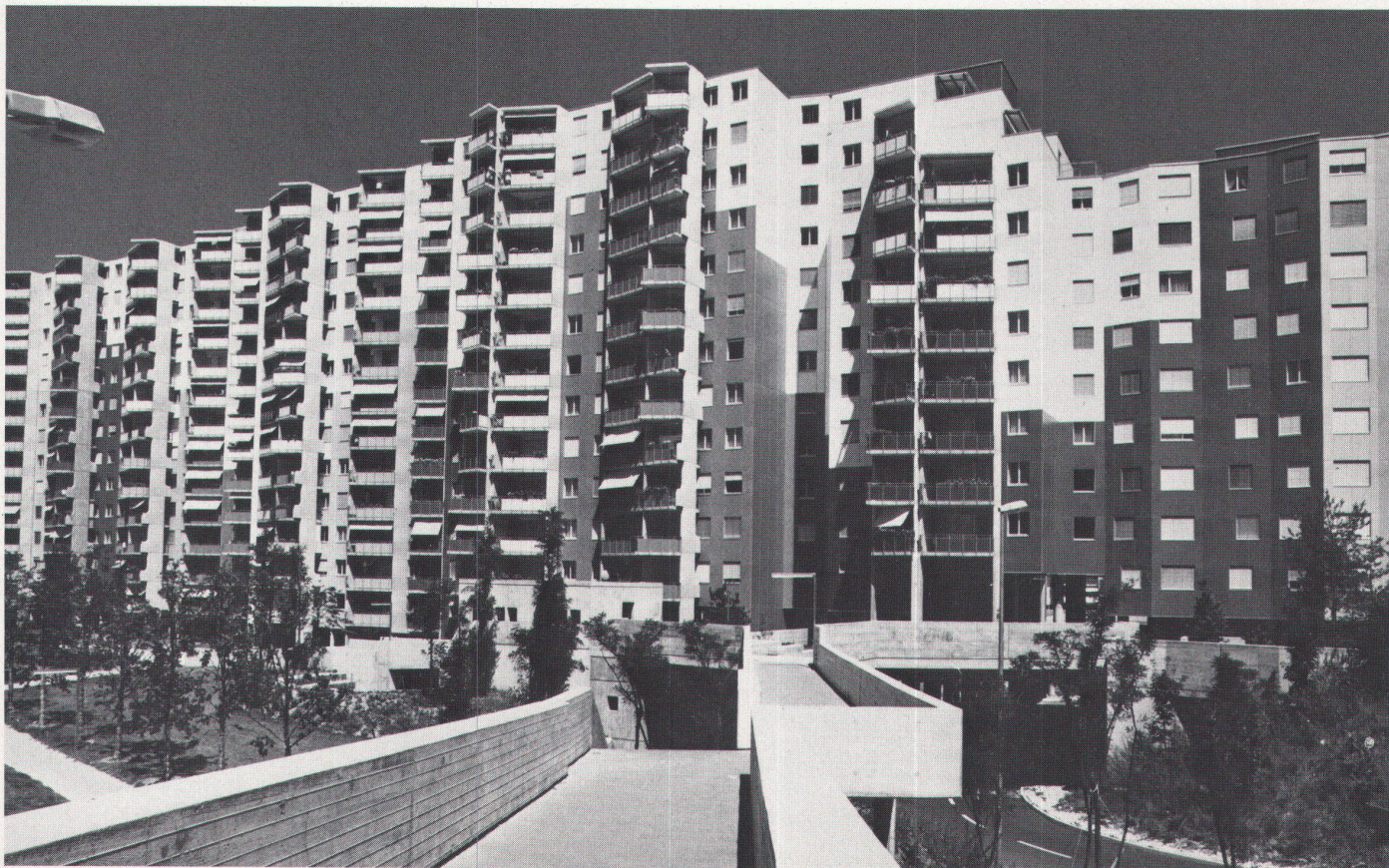
Blick von der Passerelle über die Route de Meyrin, rechts Hauptzufahrt, links Jugendhaus
