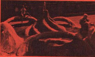
Betonstrukturen heben sich farblich von dem mit roten Klinkersteinen belegten Hof ab und bilden formal zu den Sichtbetonfassaden der Gebäude einen lebendigen Kontrast. Der Brunnen ist als Planschbecken für die anwohnenden Kinder gedacht. Material: Stahlbeton; Masse: 3,50 m/5,50 m; Baujahr: 1973
